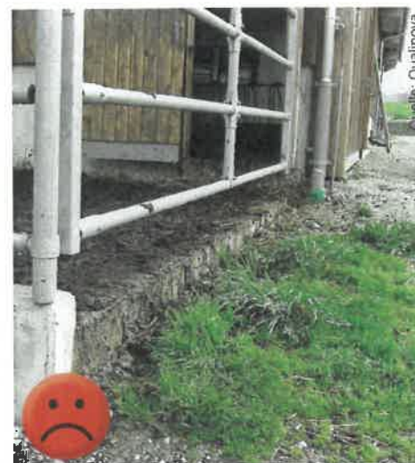
Bild links: Das Niederschlagswasser fließt ungehindert ab.
