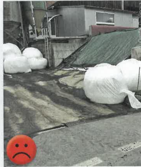
Bild links: Silosaft tritt aus der Siloanlage und versickert ungehindert.
